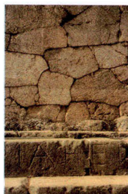
Εικ.3.20 Τοιχοποιία στη Δήλο με λαξευτούς λίθους μη κανονικού σχήματος. Η συναρμογή των λίθων είναι δυνατή μόνο με συγκεκριμένο τρόπο.
