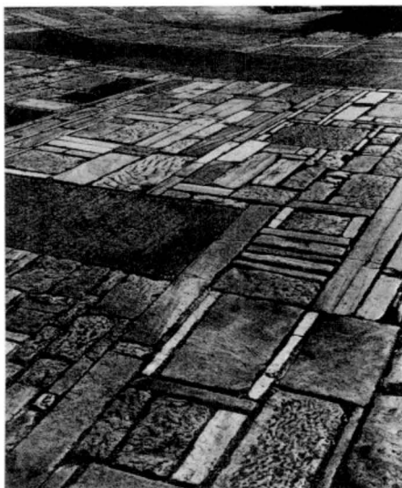
Εικ.3.26 Η πλακοστρωση στην είσοδο της Ακρόπολης, έργο του αρχιτέκτονα Δ. Πικιώνη (1964). Στο έργο συνδυάζονται ορθογωνικές πλάκες μαρμάρου με διάφορες διαστάσεις.
