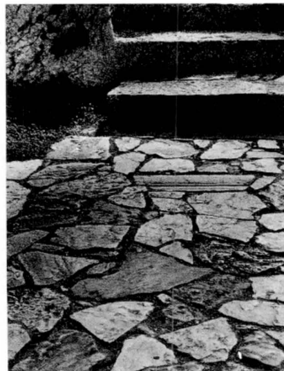
Εικ.3.27 Πλακοστρωση με μη κανονικές πλάκες στη διαμόρφωση γύρω από την Ακρόπολη, έργο του αρχιτέκτονα Δ. Πικιώνη.
